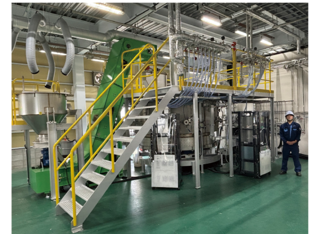
図2 今回完成した実証設備
